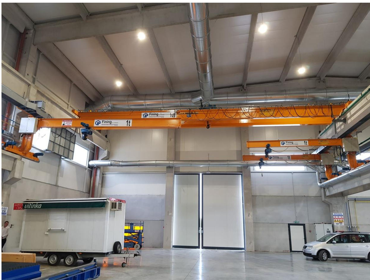
PMP JELŠINGRAD - FMG, Gradiška
