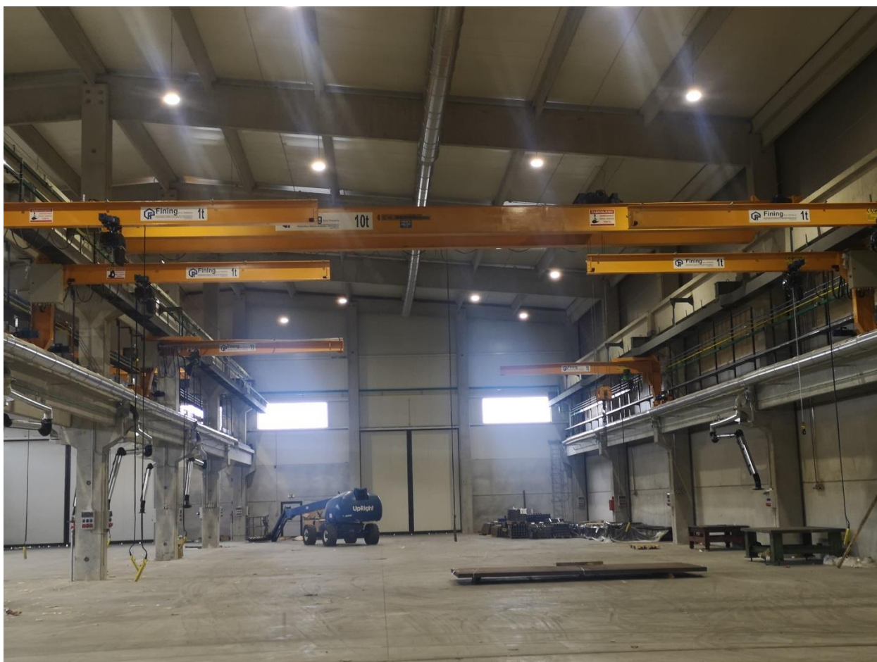
PMP JELŠINGRAD - FMG, Gradiška
