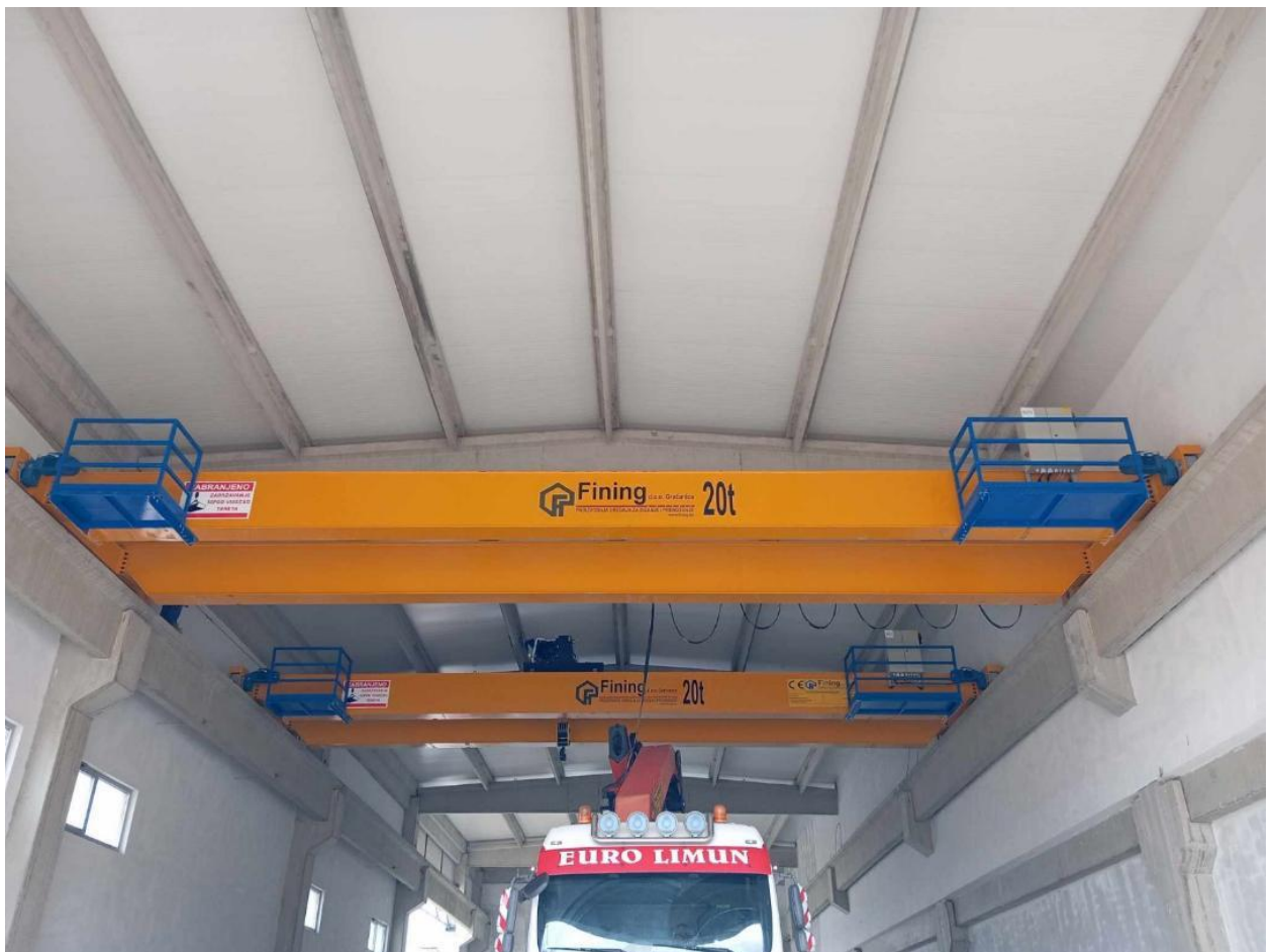
EFT RUDNIK I TERMOELEKTRANA, Stanari
